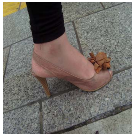
女性歩行者の歩きやすさを考慮した 歩道ブロックの設置
