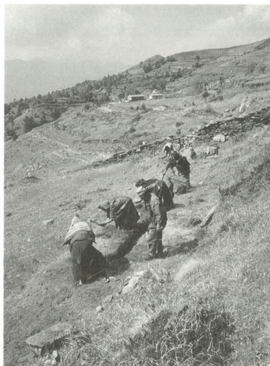
▲水道のパイプラインのための掘削作業(ネパール)
